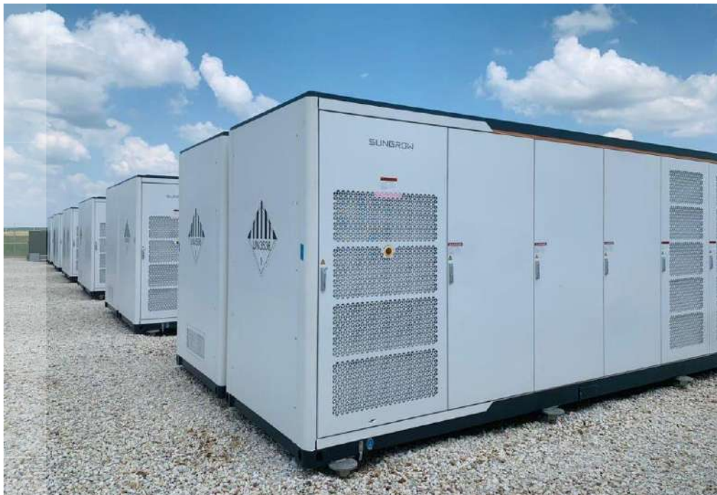
איור 4: התקנה אופיינית באמצעות כלונסאות בטון וכיסוי באמצעות אגריגט
