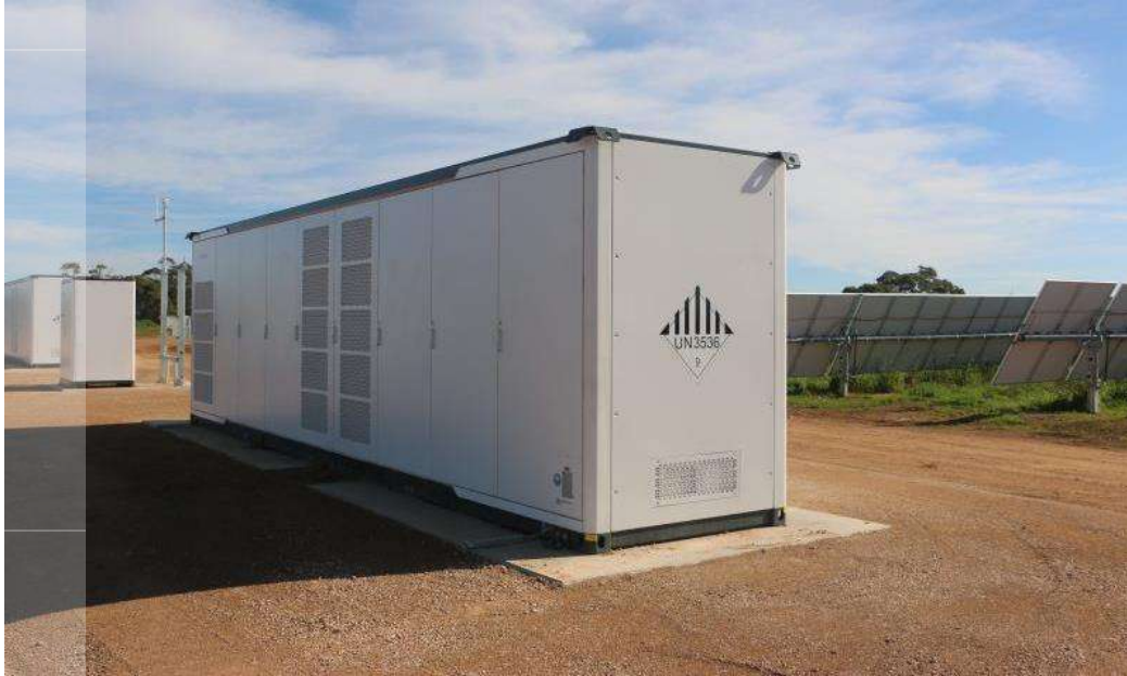
איור 3: התקנה אופיינית על גבי משטח בטון
